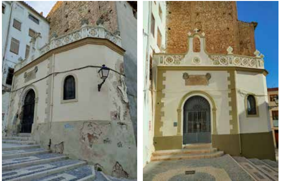
Fachada de la capilla antes y después de la restauración
